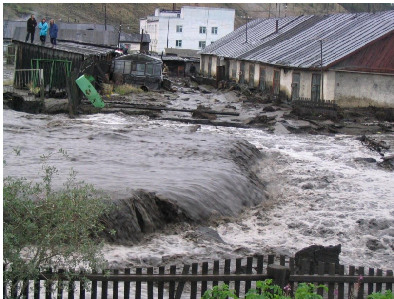
Рисунок 3 – В Верхоянском районе, в ночь с 29.07.2005 г. на 30.07.2005 г., на пос. Батагай обрушился селевой поток, который нанёс значительный урон коммуникациям, ЛЭП, жилищным и административным постройкам. Основной удар селевой поток нанёс центральной ул. Ленина. Фото Сорокиной К.М.
